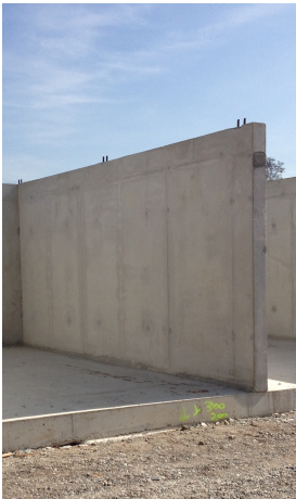
Voile béton 18 cm R_w+C = 58 dB
