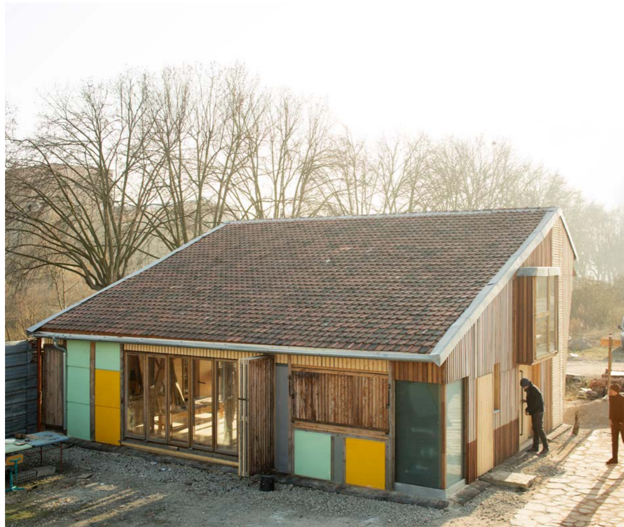
La base vie d'Actlab, à 80% en réemploi. Laboratoire et équipement de chantier dédié au réemploi de matériaux de construction. ZAC de l'éco-quartier fluvial de L'île-Saint-Denis (93). Bellastock. Photo : Clément Guillaume
